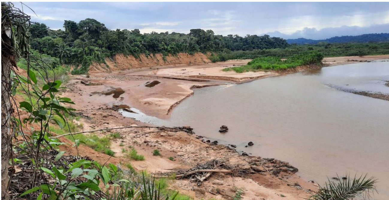
El cauce del río cambia y va afectando en la pérdida de tierra en la comunidad Asunción del Quiquibey. Practical Action.
