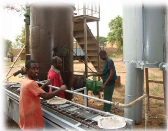
Figure 2: Unité de production de Pavés Plastiques - Ouagadougou 2
