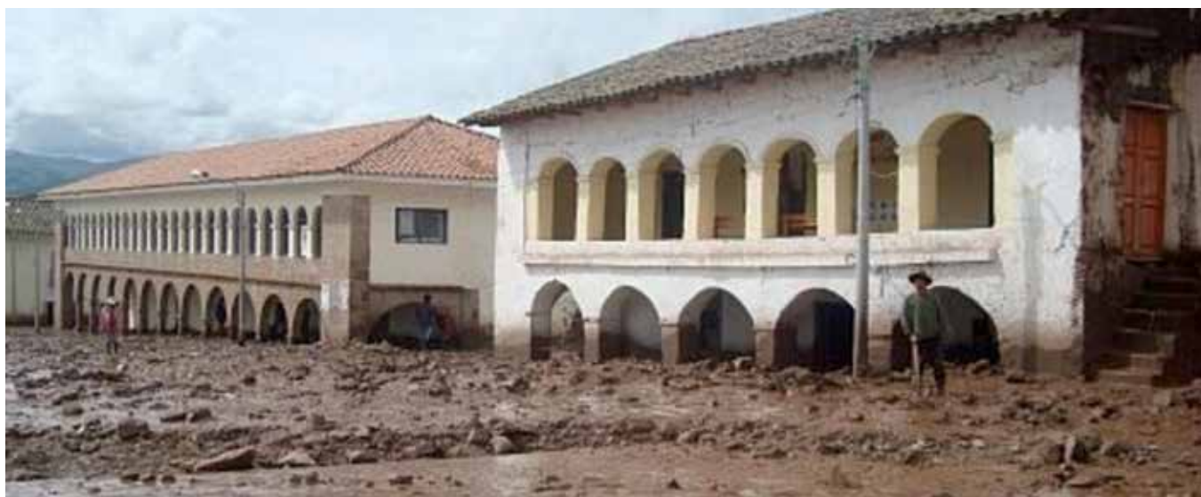
Deslizamientos en la plaza de armas de Zurite (2010).
