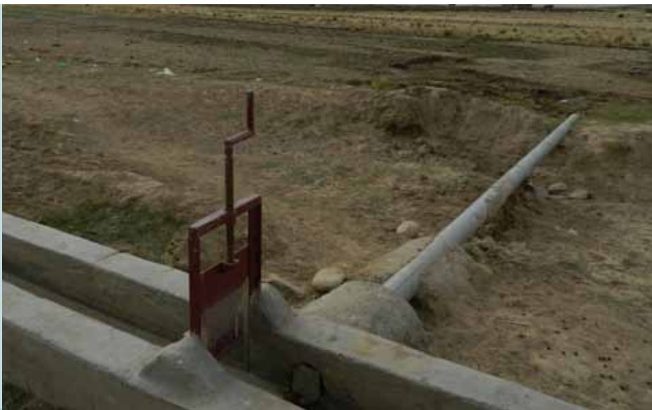
Puente de tubería de fierro galvanizado para paso de vehículos livianos
