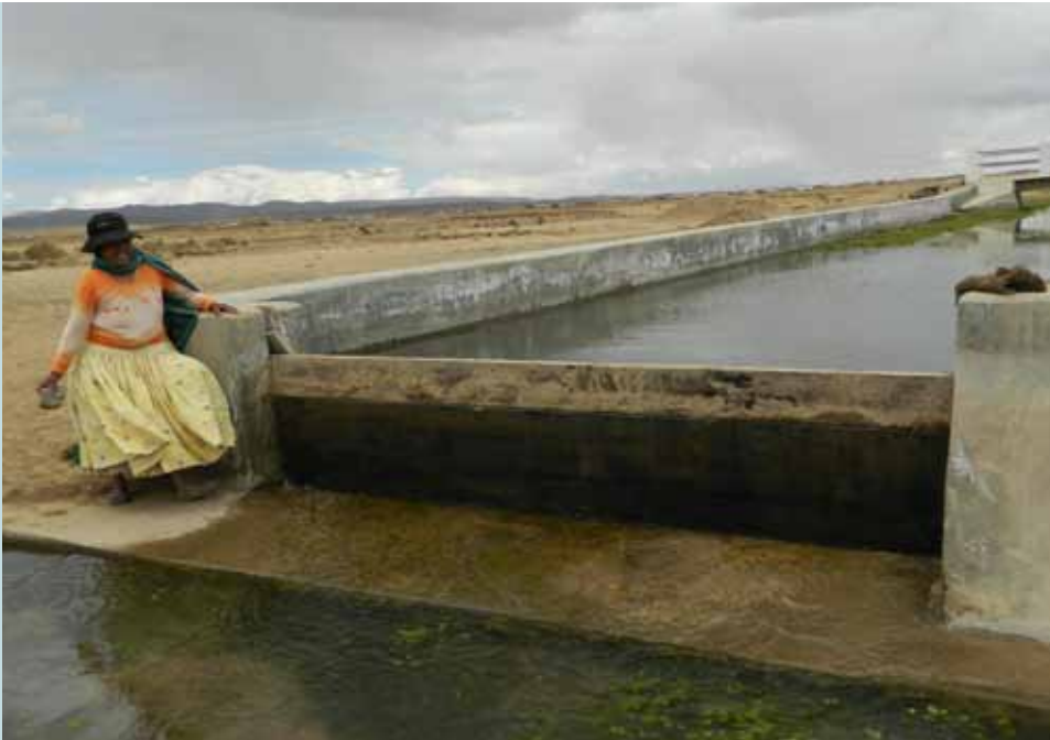
Obra de toma del sistema de microriego Collmini
