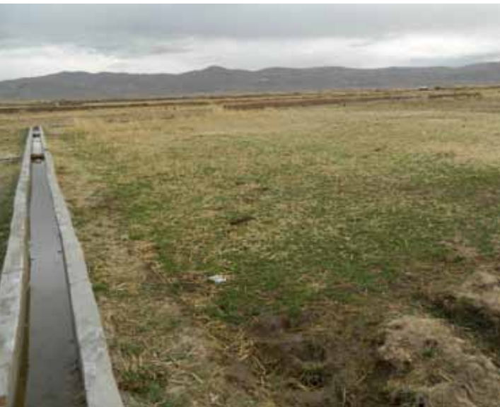
Sistema de conducción de canal abierto
