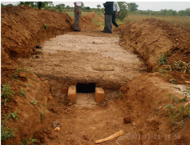
Figure 3 : des installations de stockage d'eau de 10m 3 pour éviter l'évaporation et une percolation profonde.
