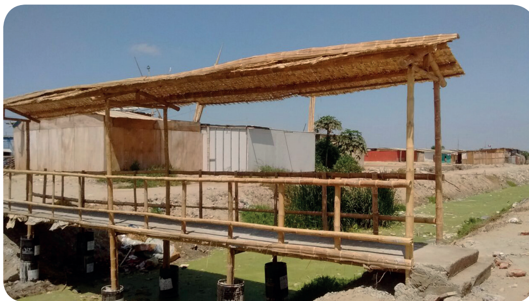
Foto N°7: Vista del dren cercano al Asentamiento Humano Polvorines
