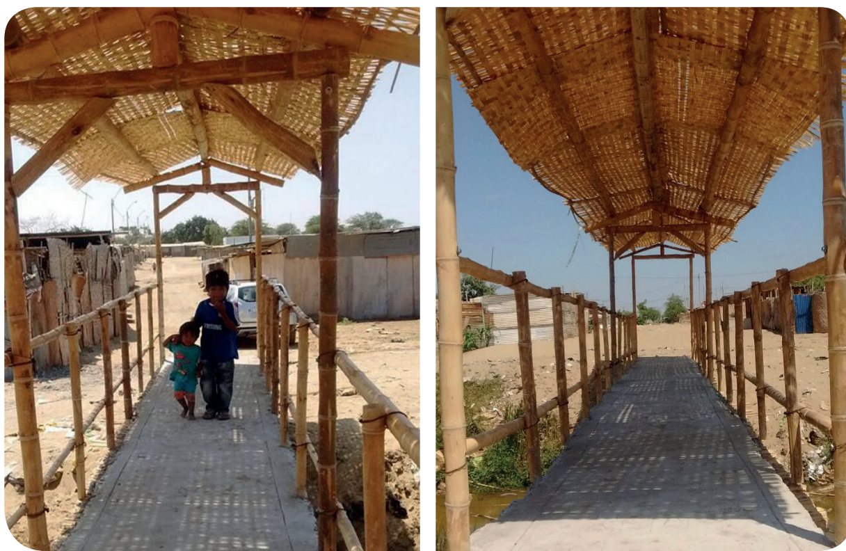
Foto N° 6: Vistas de los puentes terminados y listos para su uso
