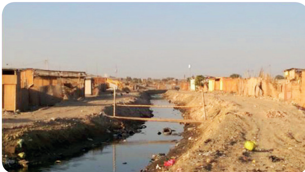
Foto N° 5: Vista del dren cercano al Asentamiento Humano Polvorines
