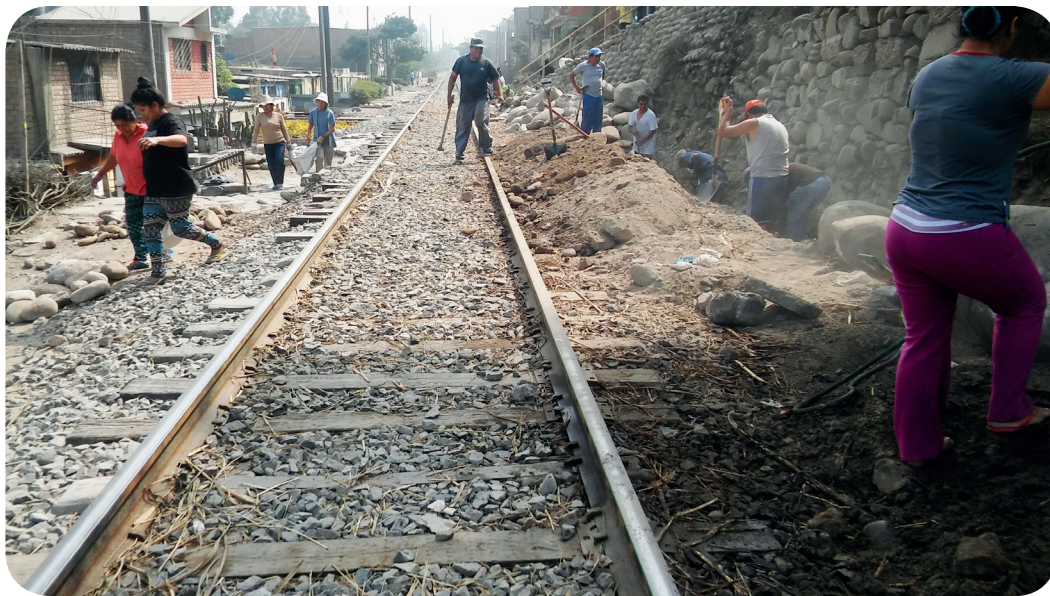
Foto N° 1: Zona Baja de Belén en periodo de creciente del río Itaya Vista de trabajo participativo en la apertura de zanjas para la cimentación del muro
