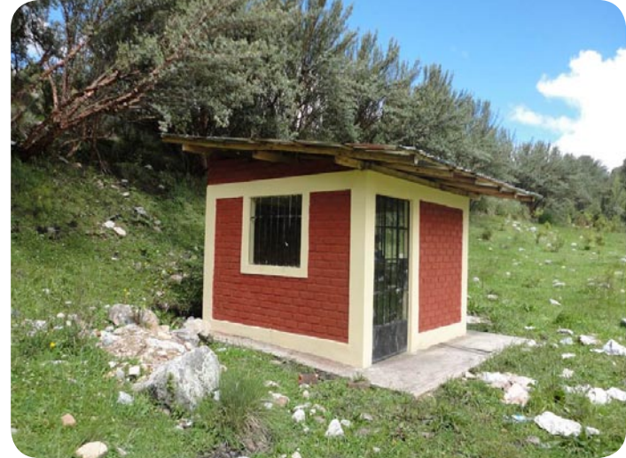
Caseta de máquina
