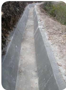
Revestido con hormigón
