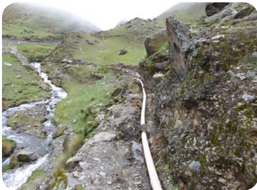
Revestido con tubería PVC
