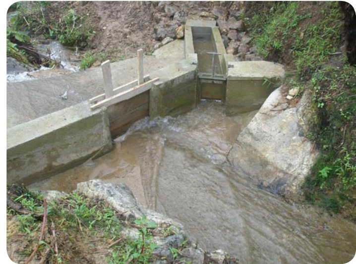
Obra de toma o rebalse
